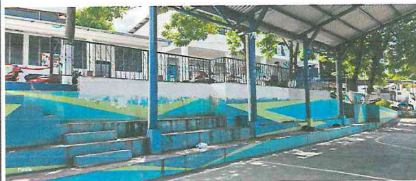
Foto 2: reparacion de bordillo en area de cancha para salida de agua
