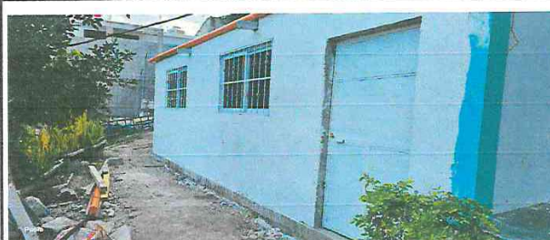
Foto 4: instalacion de ventanas y valcones de metal
