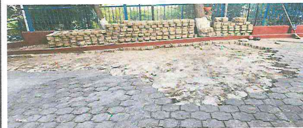
Foto 5: reparacion de adoquin en patio principal
