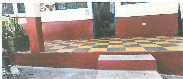
Foto 1: pintura exterior de salones de clases
